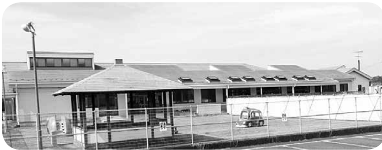
増築中のこども園舎
