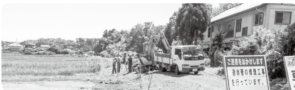
町道の埋設管破損修理
