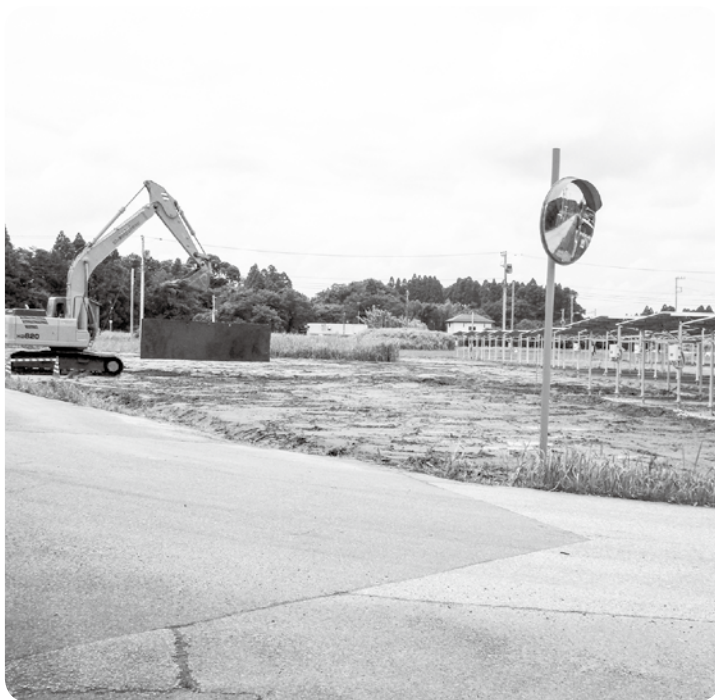
工事中の太陽光発電（上市場地先）
