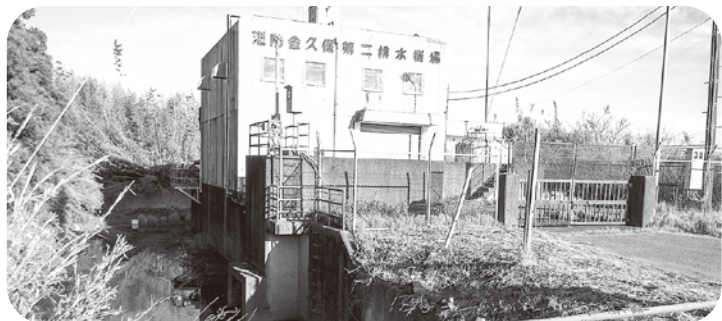
金久保第二排水機場
