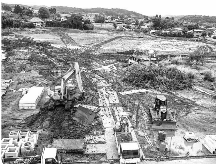
工事が進む多目的公園
