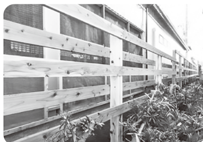
町内産木材活用の“ぶらっと”板塀
