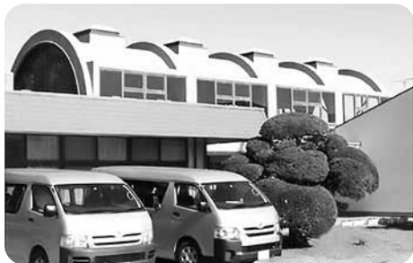
雨漏り修理した福祉交流センター
