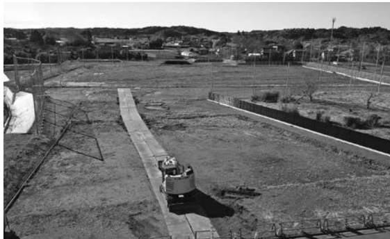
工事中の多目的広場
