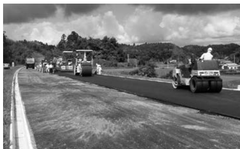
工事中の長生グリーンライン
