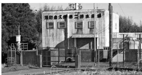
金久保排水機場
