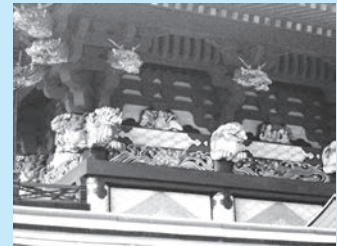
国指定重要文化財大前神社の本殿北面
