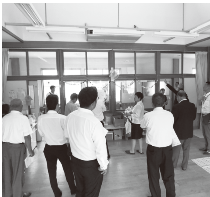
こども園・中学校エアコン設置工事
