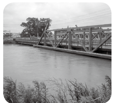
増水した南川橋
