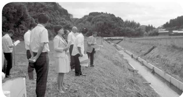
佐貫災害復旧工事現地視察
