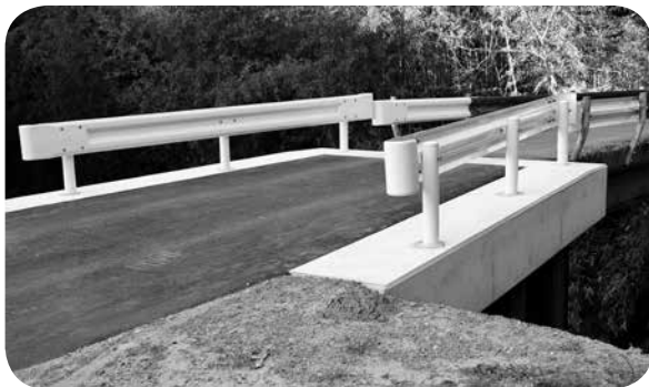
完成した榎戸橋右岸工事
