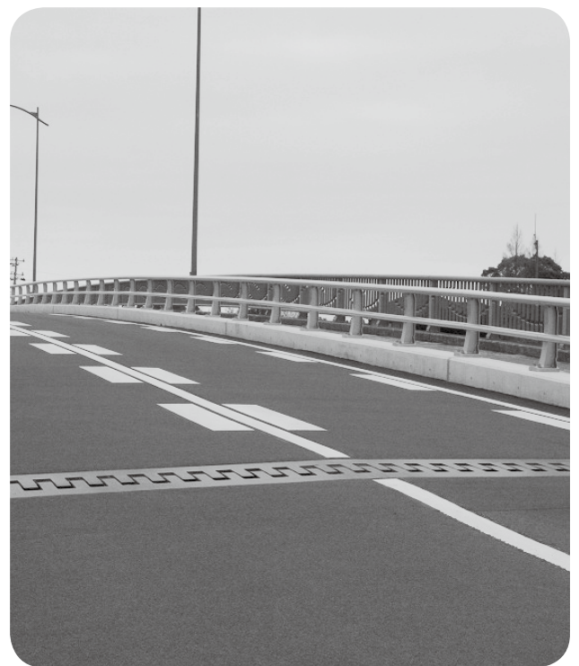
長寿命化工事後の川瀬橋
