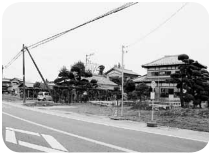
拡幅進む上市場県道
