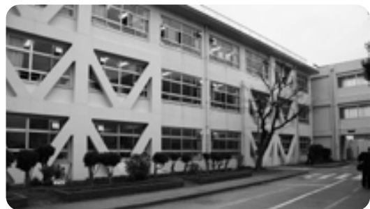
外付けブレース工法(船橋市立中野木小学校)
