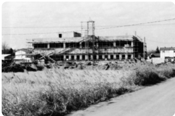
建設中の陸沢村立中央公民館
