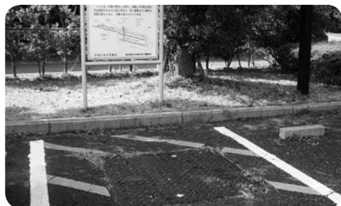
飲料水兼用耐震性貯水槽
