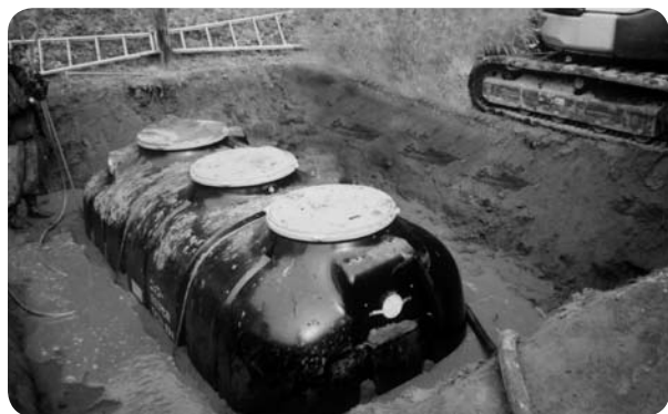
特定地域生活排水処理事業による合併処理浄化槽設置工事
