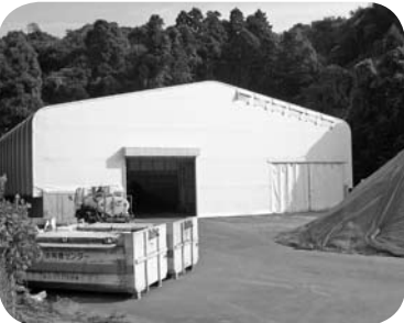
有機センター製品・副資材倉庫
