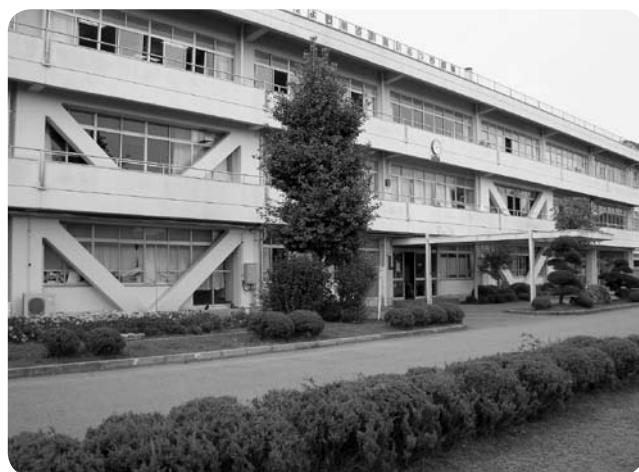
耐震補強を終えた中学校校舎
