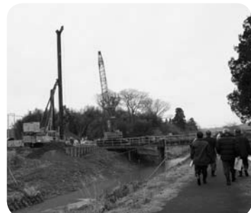
川田橋架換工事（上之郷地先）
