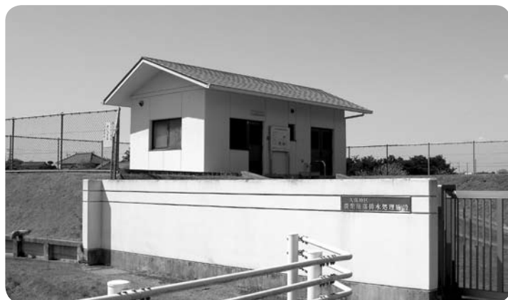
久保地区農業集落排水処理施設
