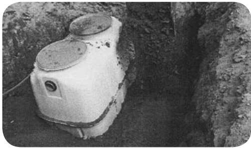
合併浄化槽設置工事
