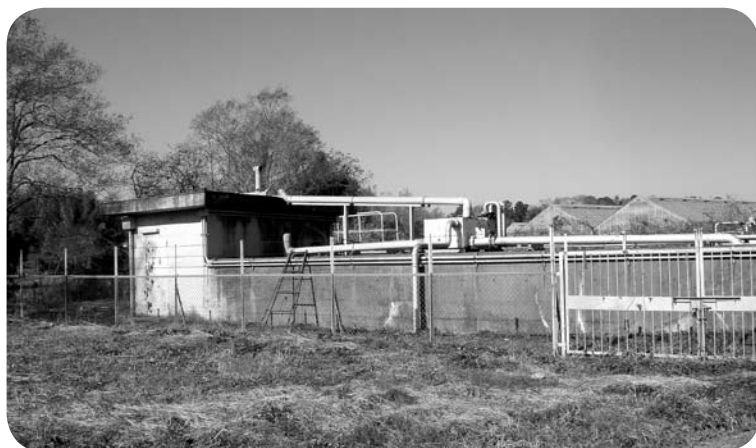
むつみニュータウン汚水処理施設
