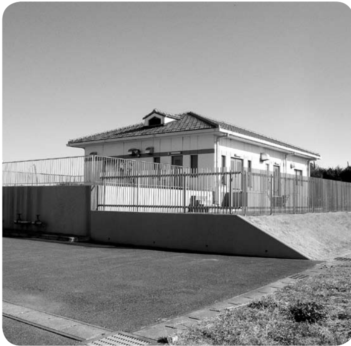
北部地区農業集落排水処理施設
