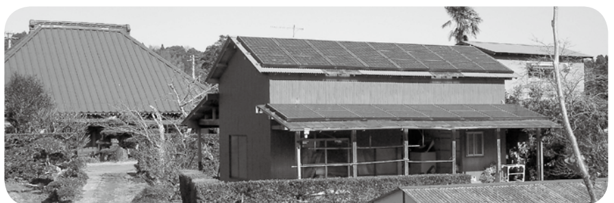
屋根に設置したソーラーパネル
