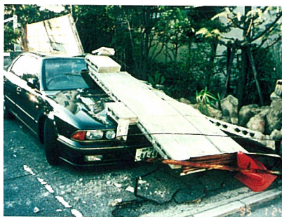
写真 地震時に倒壊したブロック塀
