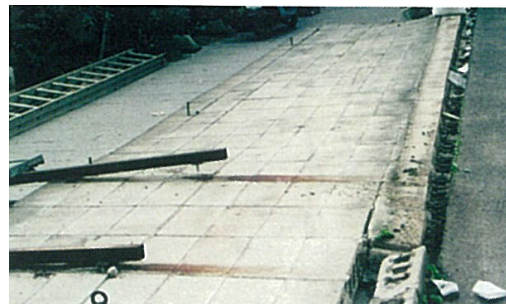
写真 地震時に倒壊したブロック塀
